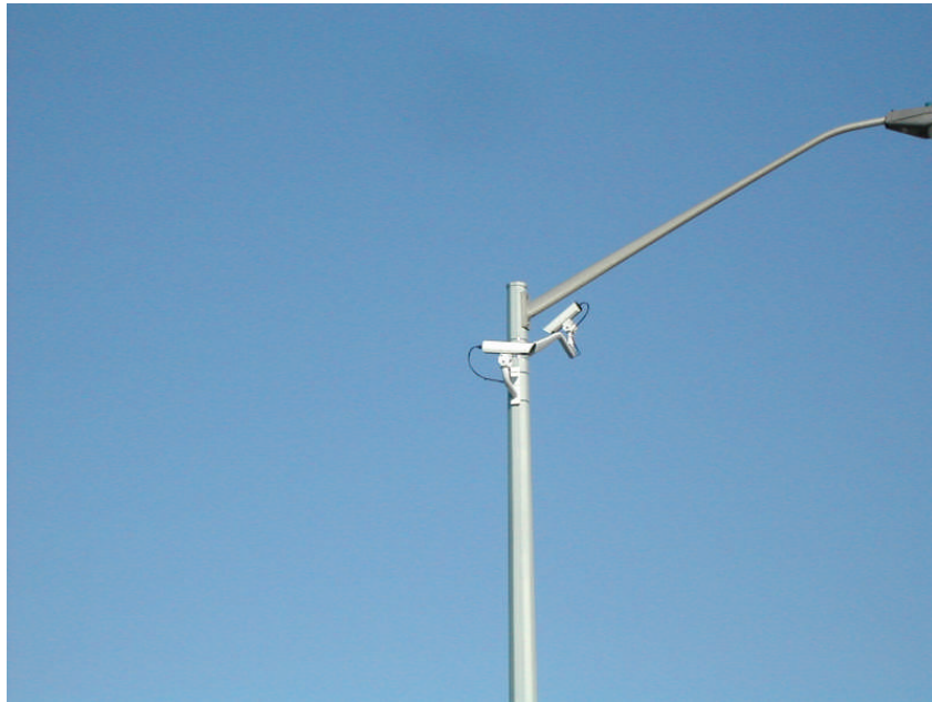
Photo 1 : Détection vidéo des véhicules – surveillance et collecte de données sur la circulation (Huron Church Road, Ontario, FIF)
