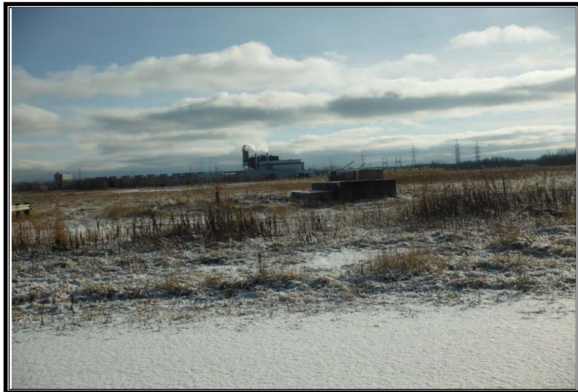
Photo 4 Ancienne infrastructure de pompage des eaux pluviales le long de la limite nord-ouest de la propriété
