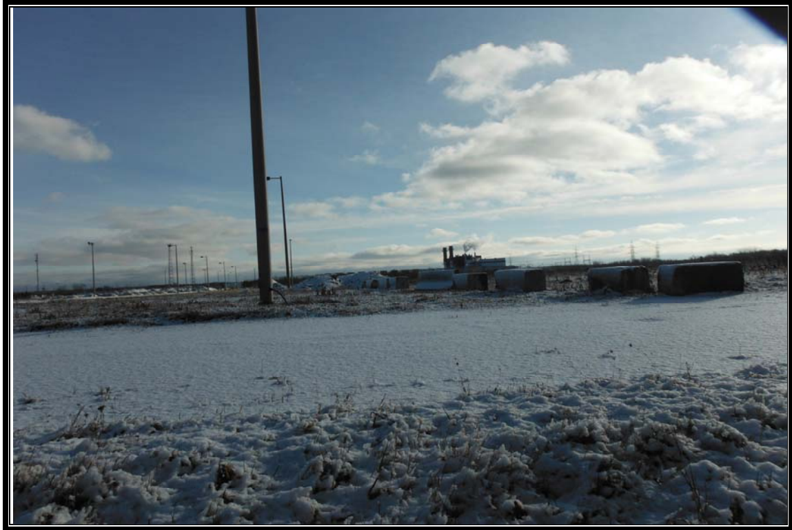
Photo 3 Blocs de béton à la limite du lot no 6 et de la propriété de SINTRA (Est)
