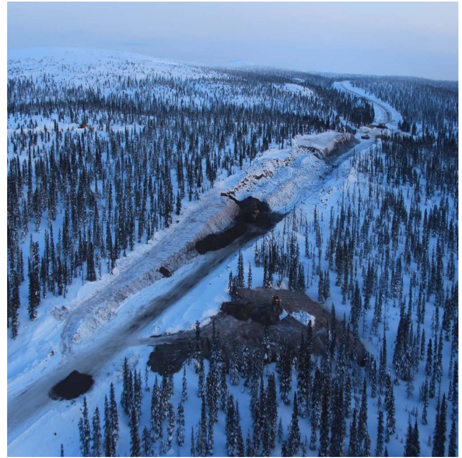
Route d'accès aux gisements Kivivic & Goodwood – Road to new deposits in 2015 completed
