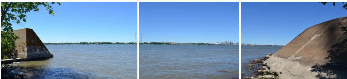
Photo 11-12 : Point de vue d'intérêt – Unité UF4 – Pylône de la rive sud (secteur de l'avenue Godefroy)
