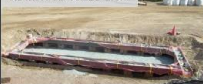
Installation d'une barrière dans le marais Sud
