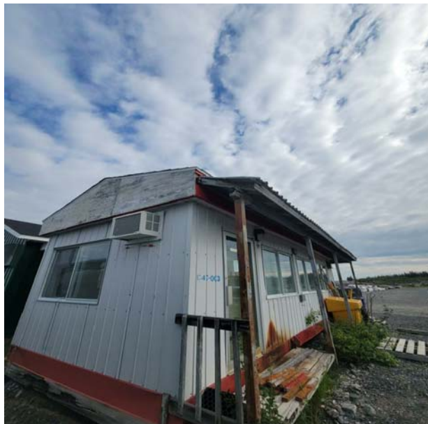
Photo 20. Photographie du 16 e bâtiment inspecté dans l'aire d'étude à la recherche de traces de présence de chiroptères cavicoles. Potentiel jugé nul.
