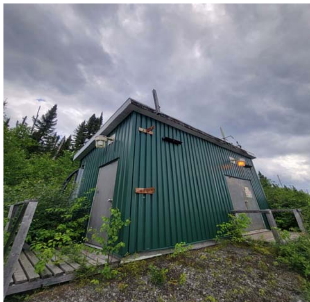
Photo 32. Photographie du 28 e bâtiment inspecté dans l'aire d'étude à la recherche de traces de présence de chiroptères cavicoles. Potentiel jugé nul.
