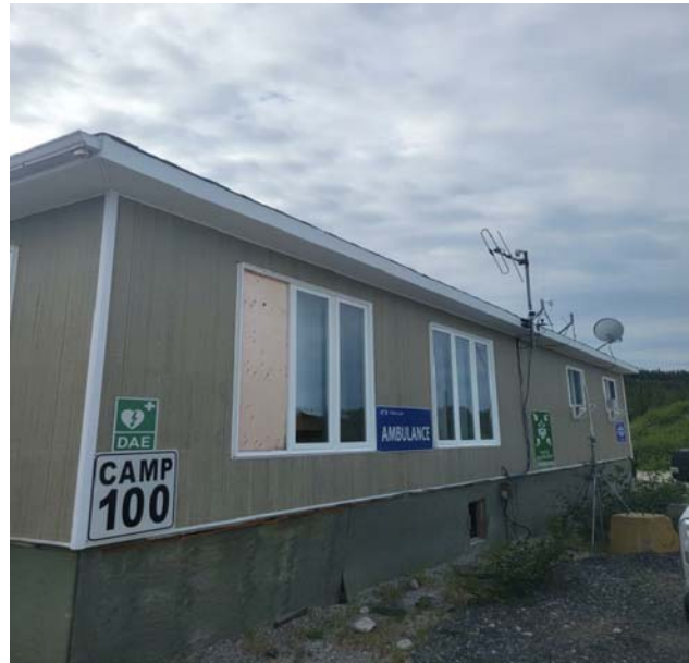
Photo 24. Photographie du 20 e bâtiment inspecté dans l'aire d'étude à la recherche de traces de présence de chiroptères cavicoles. Potentiel jugé nul.
