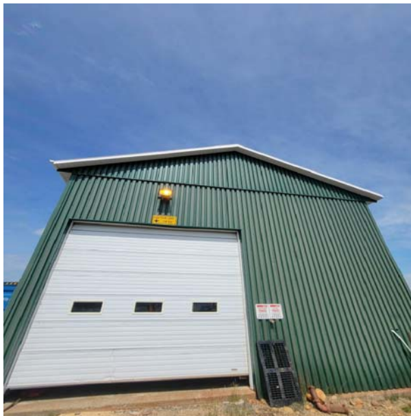
Photo 27. Photographie du 23 e bâtiment inspecté dans l'aire d'étude à la recherche de traces de présence de chiroptères cavicoles. Potentiel jugé nul.
