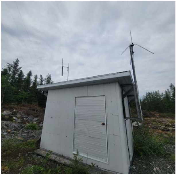
Photo 14. Photographie du 10 e bâtiment inspecté dans l'aire d'étude à la recherche de traces de présence de chiroptères cavicoles. Potentiel jugé nul.
