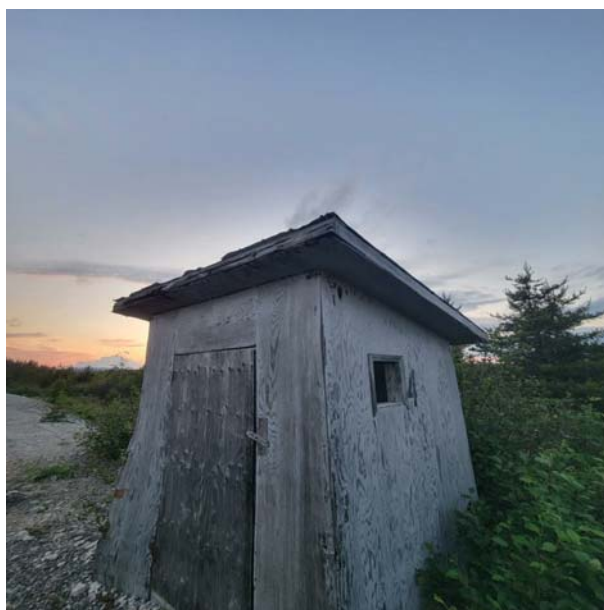
Photo 5. Photographie du 1 er bâtiment inspecté dans l'aire d'étude à la recherche de traces de présence de chiroptères cavicoles. Potentiel jugé moyen.
