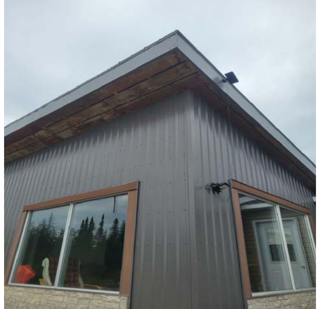
Photo 12. Photographie du 8 e bâtiment inspecté dans l'aire d'étude à la recherche de traces de présence de chiroptères cavicoles. Potentiel jugé nul.
