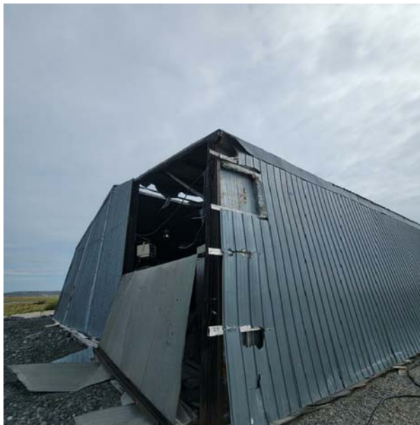
Photo 19. Photographie du 15 e bâtiment inspecté dans l'aire d'étude à la recherche de traces de présence de chiroptères cavicoles. Potentiel jugé nul.
