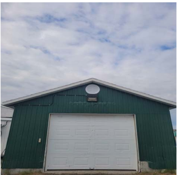
Photo 18. Photographie du 14 e bâtiment inspecté dans l'aire d'étude à la recherche de traces de présence de chiroptères cavicoles. Potentiel jugé nul.
