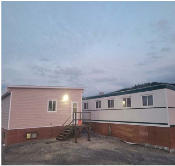
Photo 7. Photographie du 3 e bâtiment inspecté dans l'aire d'étude à la recherche de traces de présence de chiroptères cavicoles. Potentiel jugé nul.
