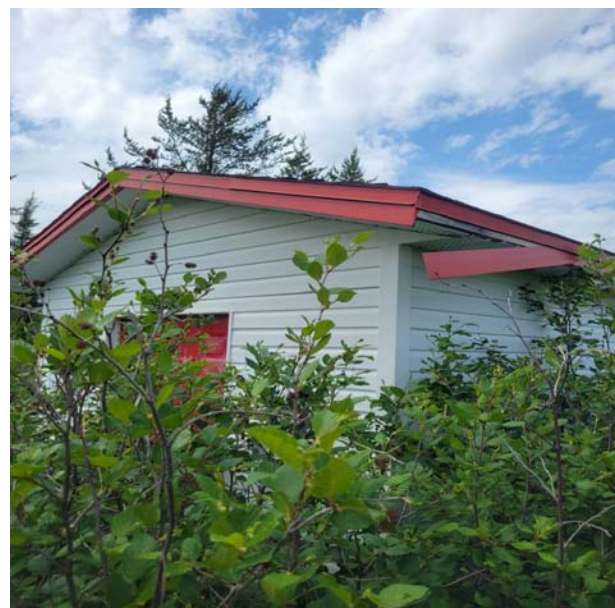
Photo 30. Photographie du 26 e bâtiment inspecté dans l'aire d'étude à la recherche de traces de présence de chiroptères cavicoles. Potentiel jugé moyen.
