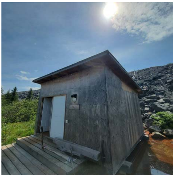
Photo 29. Photographie du 25 e bâtiment inspecté dans l'aire d'étude à la recherche de traces de présence de chiroptères cavicoles. Potentiel jugé faible.
