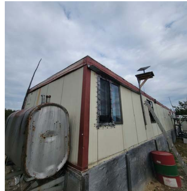
Photo 10. Photographie du 6 e bâtiment inspecté dans l'aire d'étude à la recherche de traces de présence de chiroptères cavicoles. Potentiel jugé moyen.
