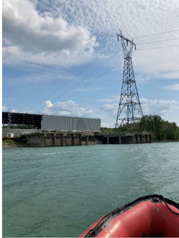
Deux structures de béton – Vue vers l'amont – 25 août 2021
