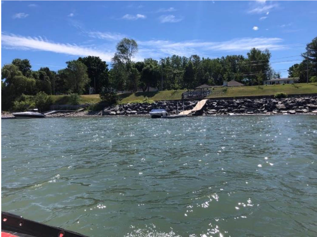
Photo 7 Berge anthropisée (enrochement) en amont du quai projeté
