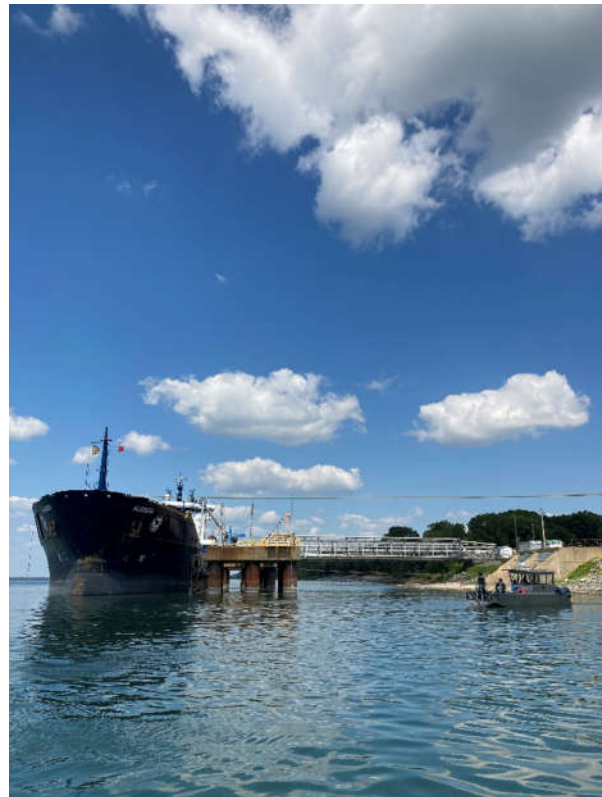
Bateau au quai en fonction – Vue vers l'aval – 25 août 2021
