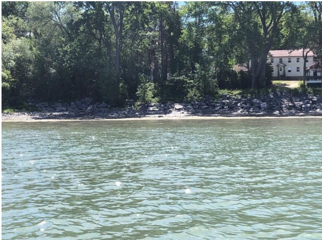
Photo 8 Berge anthropisée (enrochement) en amont du quai projeté
