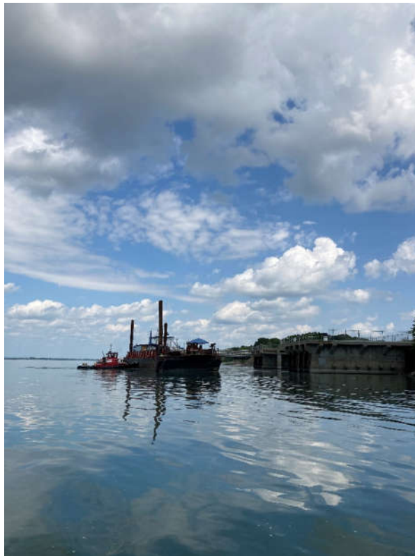
Barge et structures de béton – Vue vers l'aval – 25 août 2021
