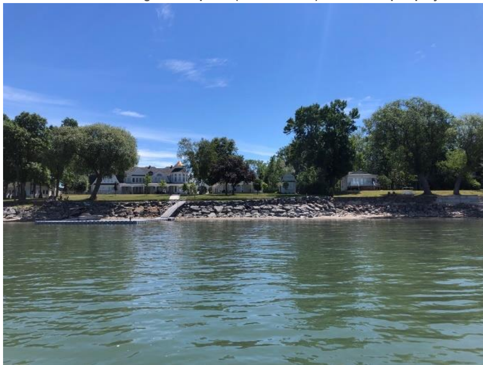
Photo 11 Berge anthropisée (enrochement) en aval du quai projeté
