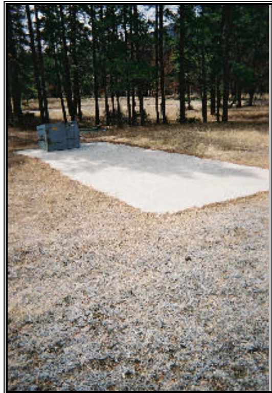
Photo 4. Plateforme d'avitaillement en béton
