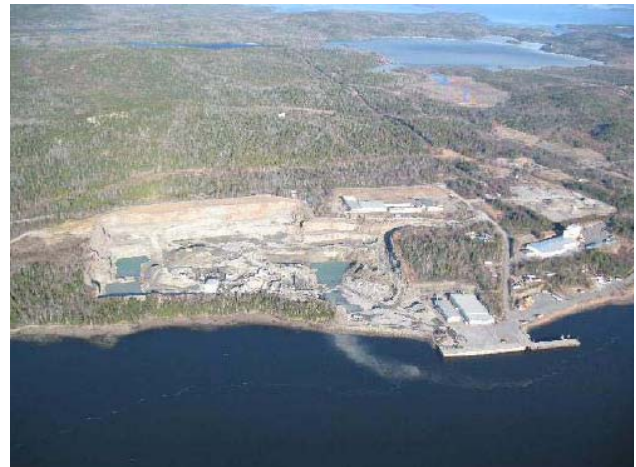
Fig. 2-14 – Au Nouveau-Brunswick, la carrière Bayside produit des granulats en vue de l'exportation.
