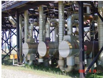
Photo 11 - Échangeurs de chaleur pour l'effluent de procédé/l'eau d'alimentation de procédé
