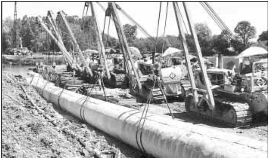
Figure 9. Franchissement par passage dans l'eau
