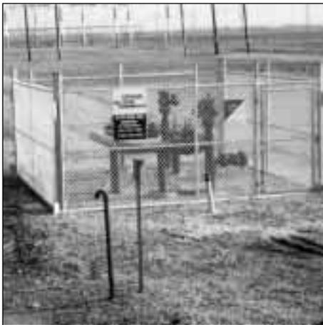
Figure 13. Station de vannes de canalisation principale
